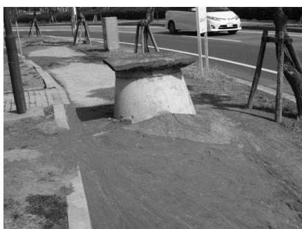
写真3 抜け上がったマンホール 切られたアスファルトが載っている 前方にもある
